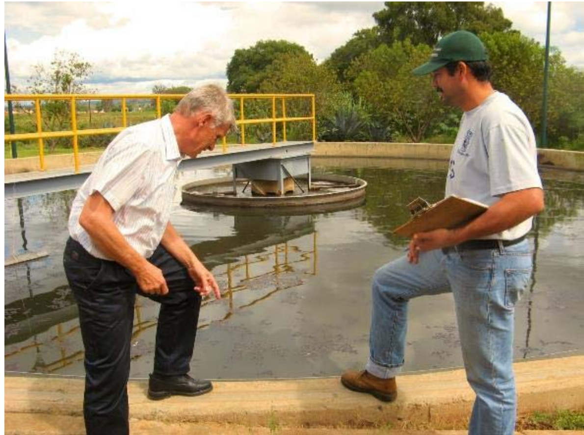
Inspeccionando la planta purificadora de aguas residuales en La Piedad, Mich.
